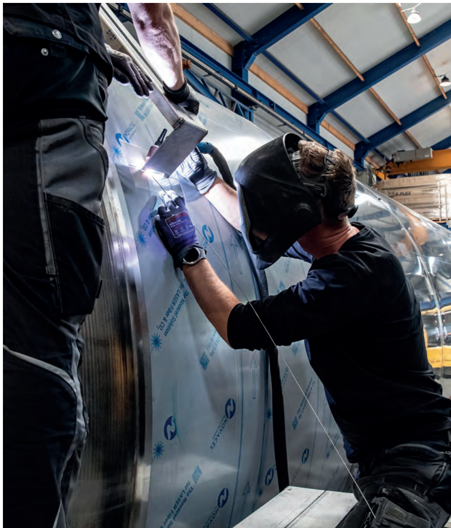
Een medewerker last aan een tank.
